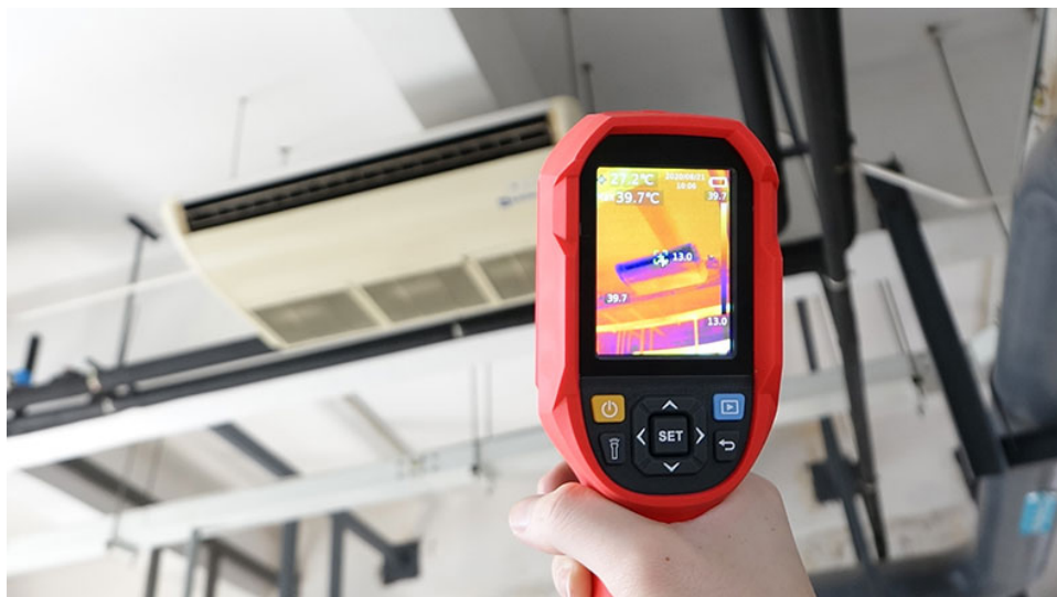
Klimatyzacje, wentylacje, inspekcja HVAC
