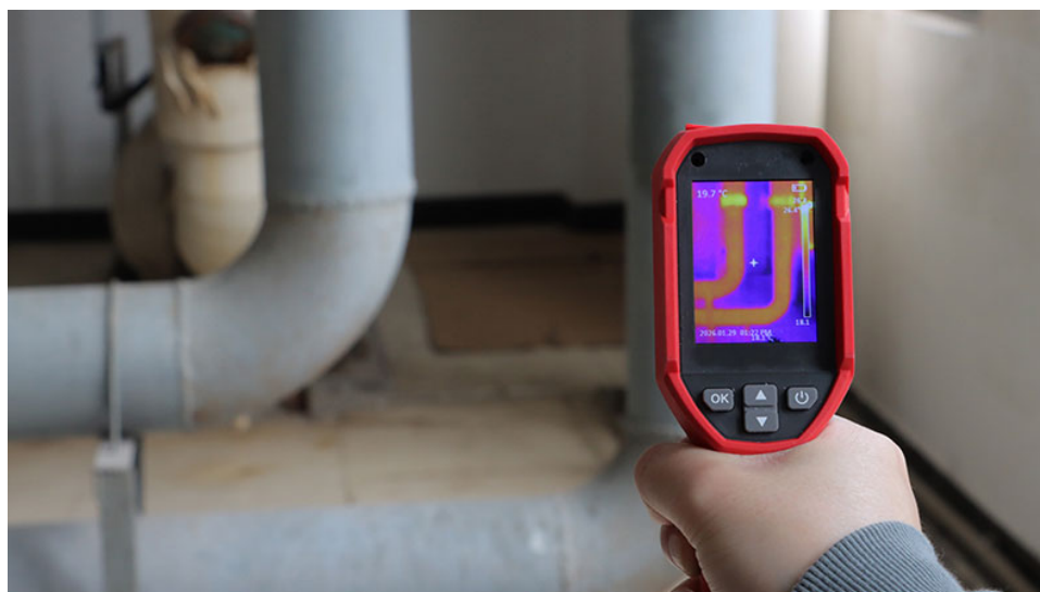
Ogrzewanie, ciepłownictwo, hydraulika - instalacje rurociągów
